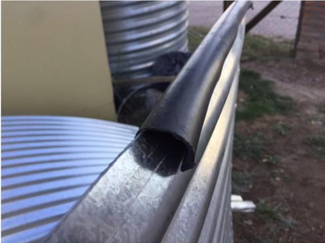
En tanques de chapa galvanizada el borde cortante de los mismos sumado al peso que el agua ejerce sobre la funda, con el paso del tiempo puede terminar cortando la misma. Muchas veces también, el uso de mangueras sobre el borde o animales que se apoyan contra el tanque para tomar agua terminan cortando la funda la cual irremediablemente no tienen posibilidad de ser reparada. A tal efecto, recomendamos la utilización
